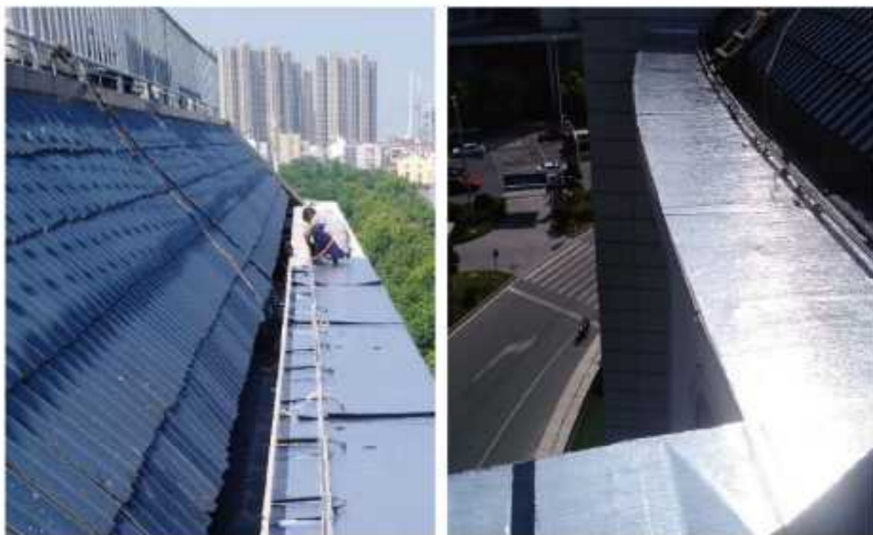
随州都市兰亭项目施工现场
