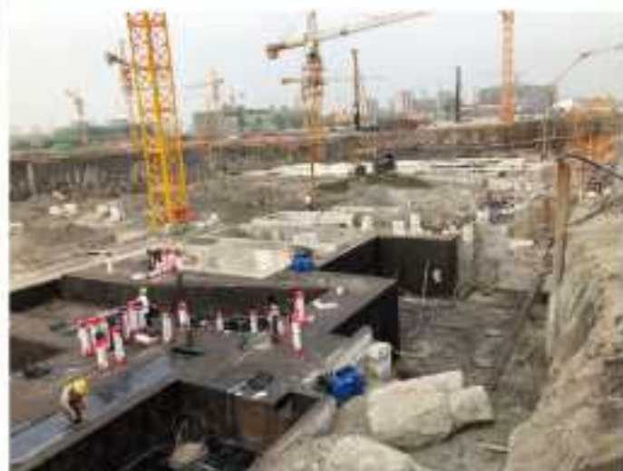
中国安居养老福利示范社区项目施工现场
