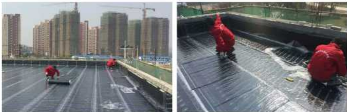
海洋世界项目施工现场
